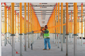
Stropní bednění
