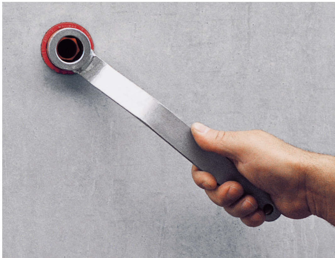
Demontáž DK těsnicích kónusů pomocí DK klíče UNI.
