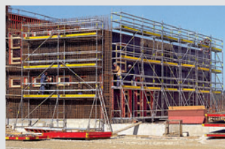
Pracovní lešení na staveništích
