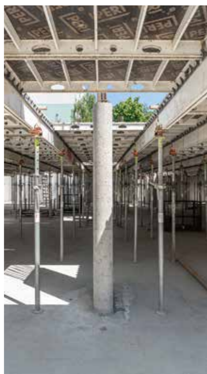
10 Velké plochy stropů s bedněním SKYDECK Bytový dům Opatov, Praha
