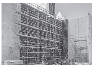
Pracovní lešení na staveništích
