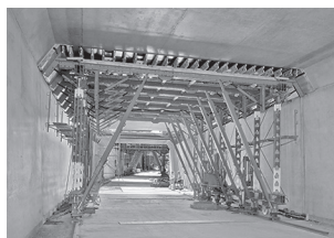
Bednění tunelů
