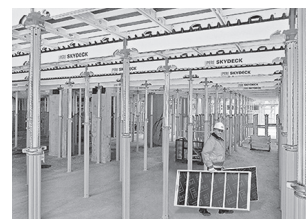
Stropní bednění
