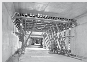
Bednění tunelů
