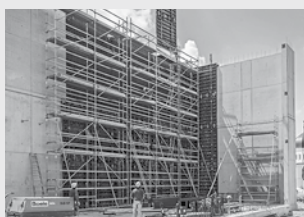
Pracovní lešení na staveništích
