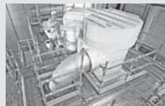
Pracovní lešení na staveništích
